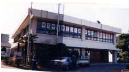
建築年次：昭和 37 年 構造規模：鉄筋コンクリート造 2 階建
