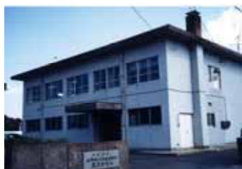
建築年度：昭和 48 年 構造規模：鉄筋コンクリート 2 階建
