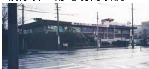
建築年次：昭和 38 年 構造規模：鉄筋コンクリート造 2 階建
