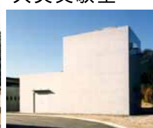
・火災実験室
