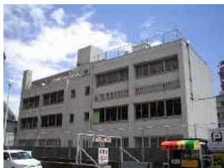
建築年次：昭和 45 年 構造規模：鉄筋コンクリート造 2 階建
