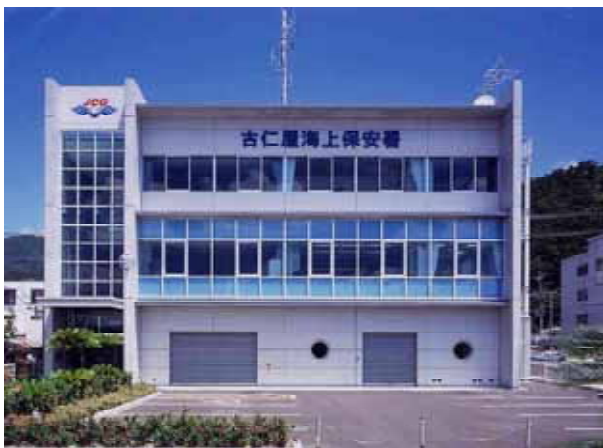
庁舎外観・内観
