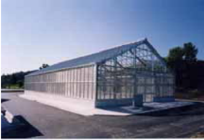
[堆肥舎] 鉄骨造 平屋建 延面積259㎡
