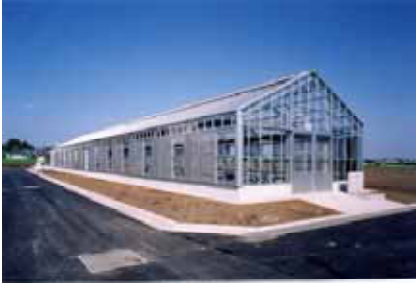
[いぐさ保存網室] 鉄骨造 平屋建 延面積199㎡
