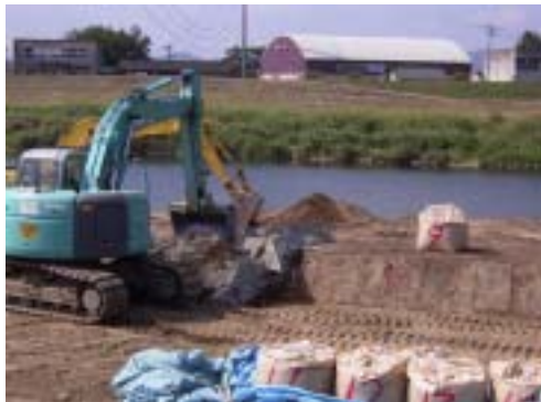
固化材混入状況
