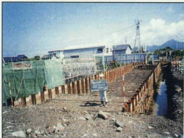
仮設工(鋼矢板締切り)
