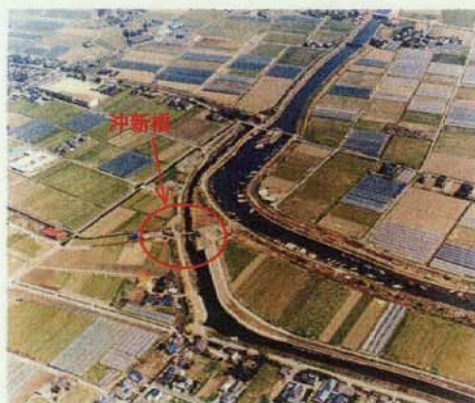
沖新橋架替前
