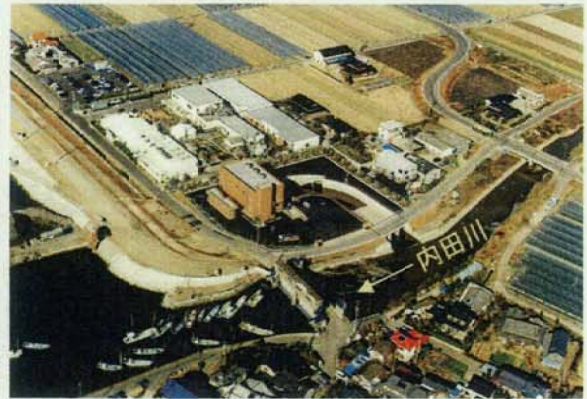
内田川排水機場、内田川水門(上空より)
