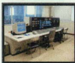
内田川排水機場操作室
