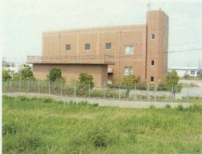
内田川排水機場
