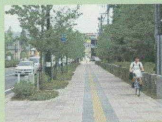
■拡幅後の歩道(大村公園前)
