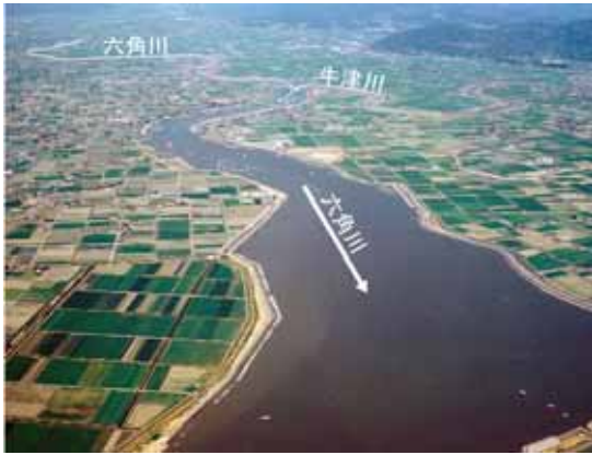
六角川河口から 1km 付近
