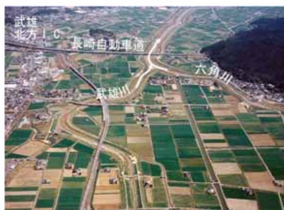
六角川河口から 26km 付近 河川-1-5
