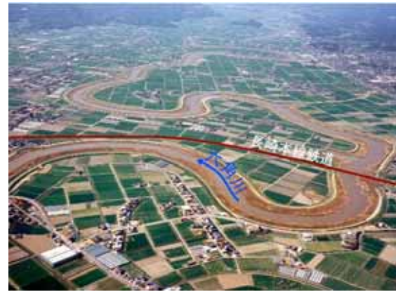
六角川河口から 14km 付近
