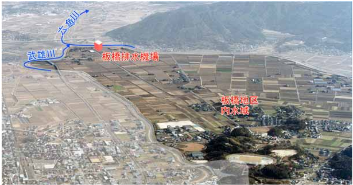
写真 1.1 板橋地区内水域
