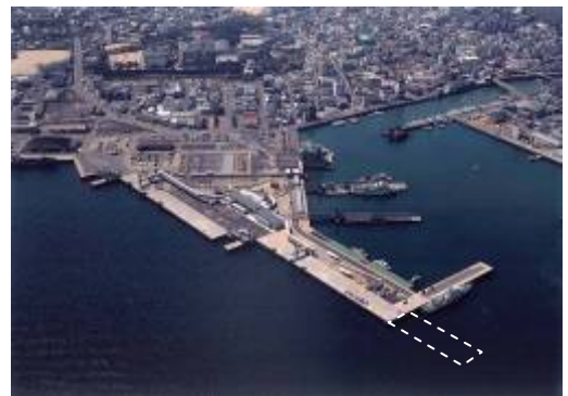
整備状況写真(H16d撮影)
