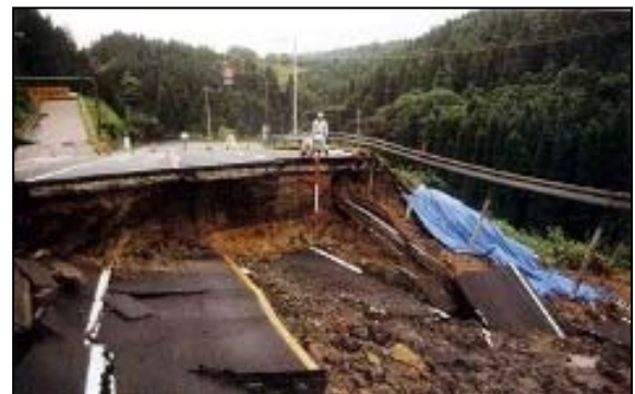
▲ 被災状況(H 5年 8月)
