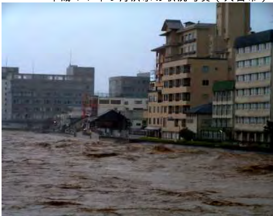
平成17年9月洪水の状況写真(人吉市)
