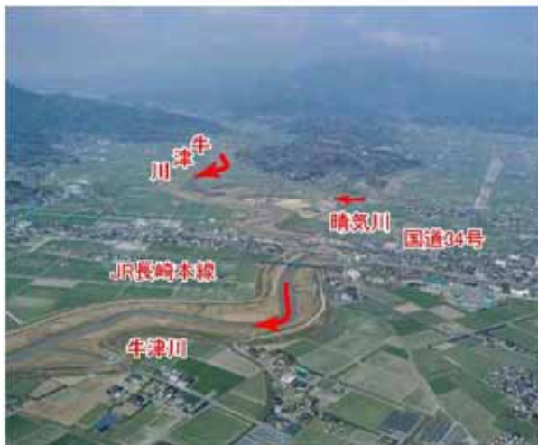
JR長崎本線、国道34号が横断する 牛津川砥川大橋付近 (六角川合流点から8km付近)
