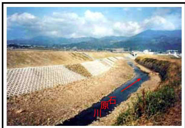
多自然型ブロック施工直後
