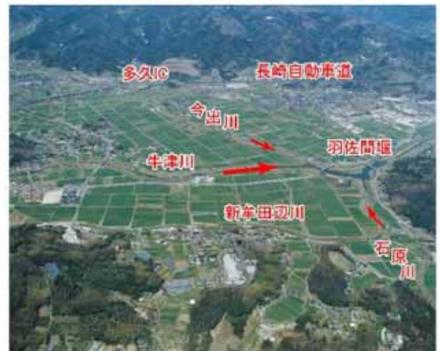
3川が合流する牟田辺地区 (六角川合流点から15km付近)
