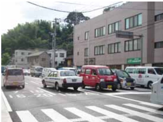
未供用区間に並行する国道35号の混雑状況
