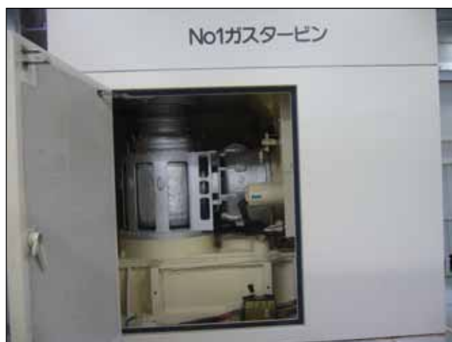
写真 1.9 立型ガスタービンエンジン
