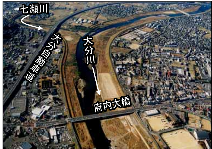
写真 1.2 大分川中流域（府内大橋付近）
