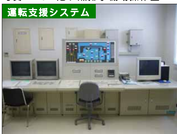
写真 1.10 ニヶ瀬排水機場操作室
