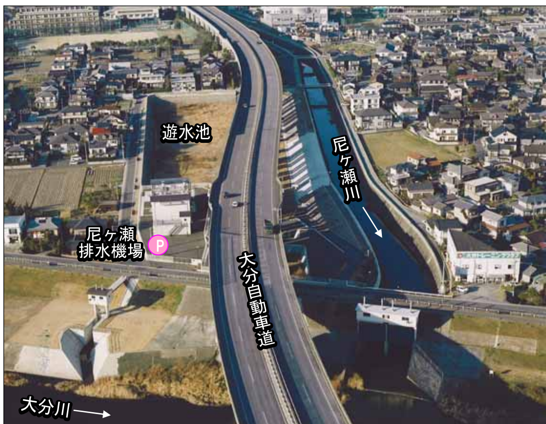
写真 1.5 尼ヶ瀬排水機場の周辺状況
