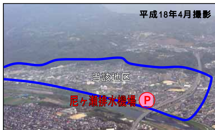
写真 2.1 排水機場周辺の状況
