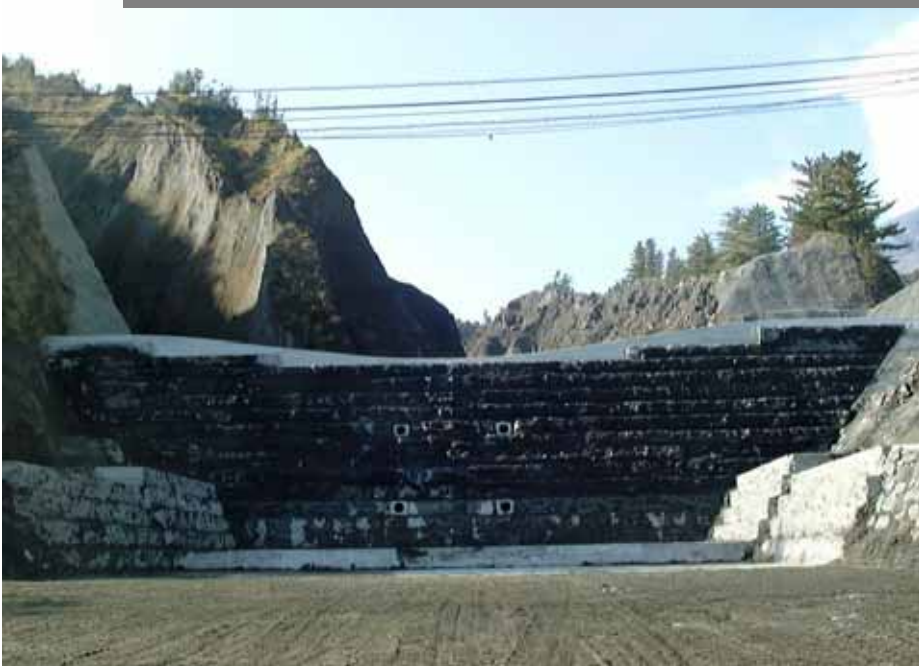
ISM工法にて実施した鍋山谷止工(黒神川)
