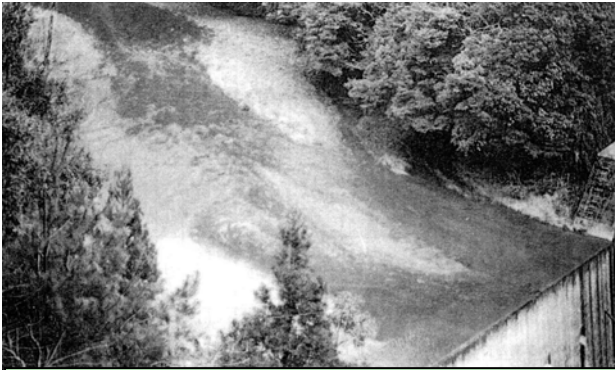
蒲牟田第1砂防えん堤 (流出土砂の捕捉・調節)
