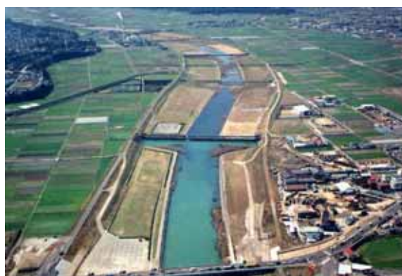
沖水川流路工
