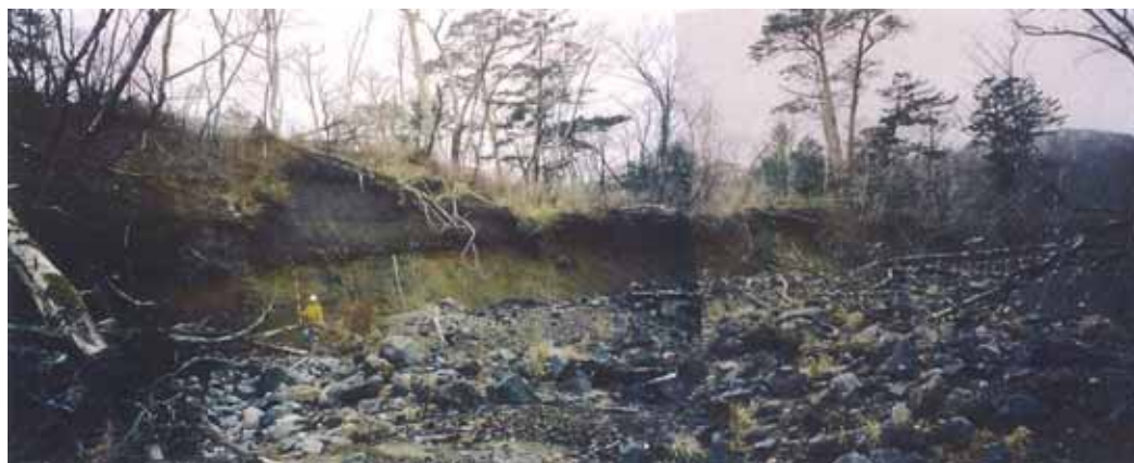
写真-3 矢岳川上流部の溪岸崩壊
