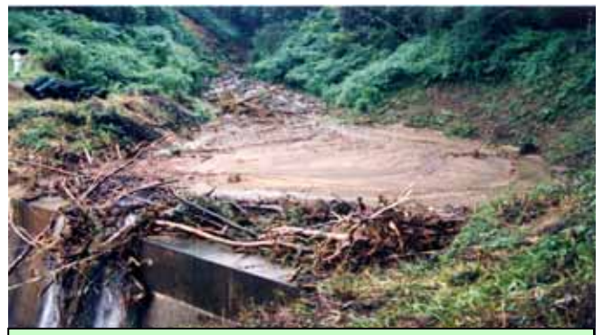
東霧島第4砂防えん堤 (土石流・流木の捕捉)
