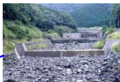
矢岳床固工群に堆積した巨石
