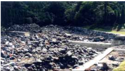
矢岳床固工群 (河床生産の抑制、溪岸侵食の防止)
