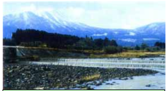
蒲牟田流路工 (溪岸侵食の防止・河床勾配安定化)
