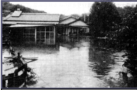
高崎川の堤防決壊により浸水
