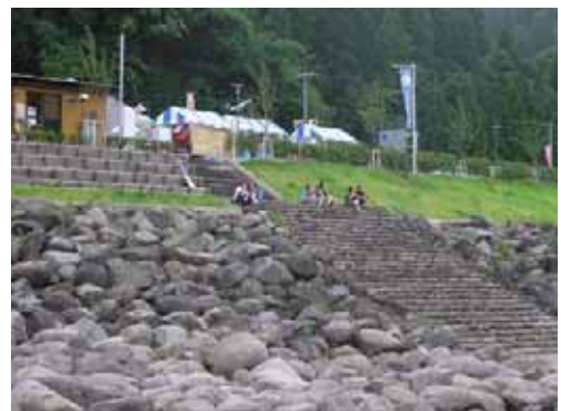
西大山水辺プラザ付近の親水階段の利用
