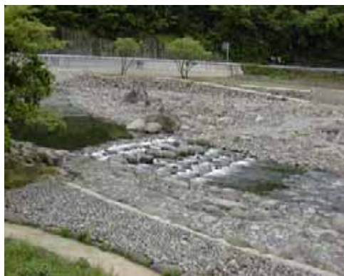
せせらぎ水路と水辺の散策路、飛び石
