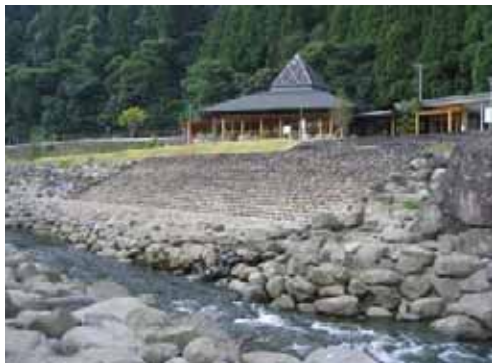
緩傾斜堤防と親水階段
