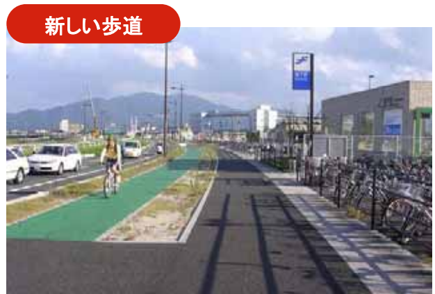
整備済み歩道(橋本駅前)
