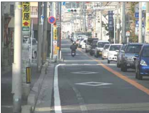
(主)大野城二丈線：やよい坂方面をみた交差点状況
