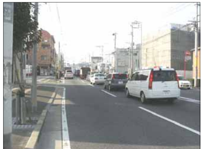
国道 385 号：春日市方面からみた交差点状況
