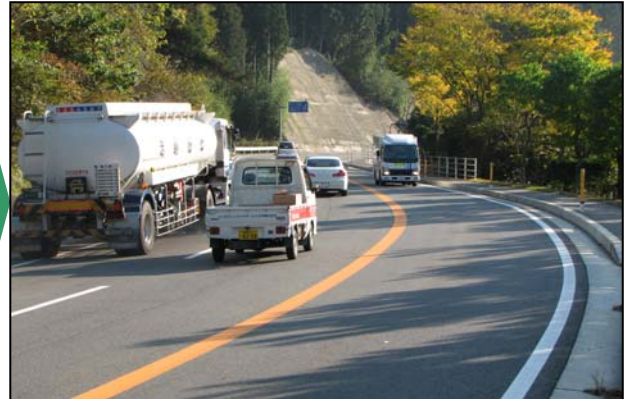
▲ 一部登坂車線区間もある現218号
