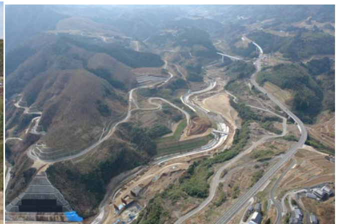
貯水池予定地内工事用道路 施工状況
