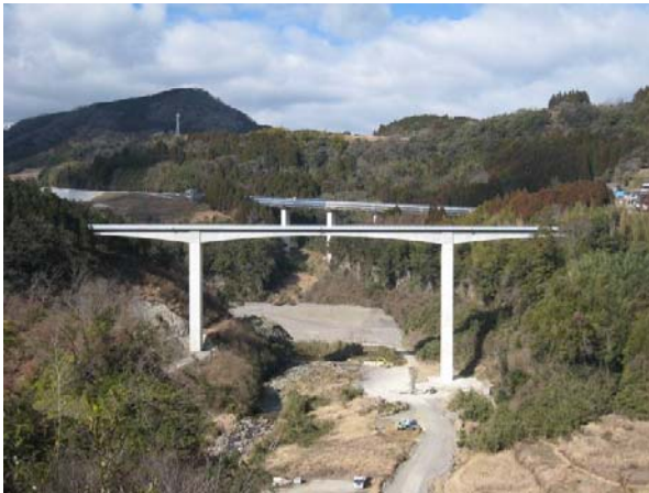
付替市道尾原線 H20.5 完成
