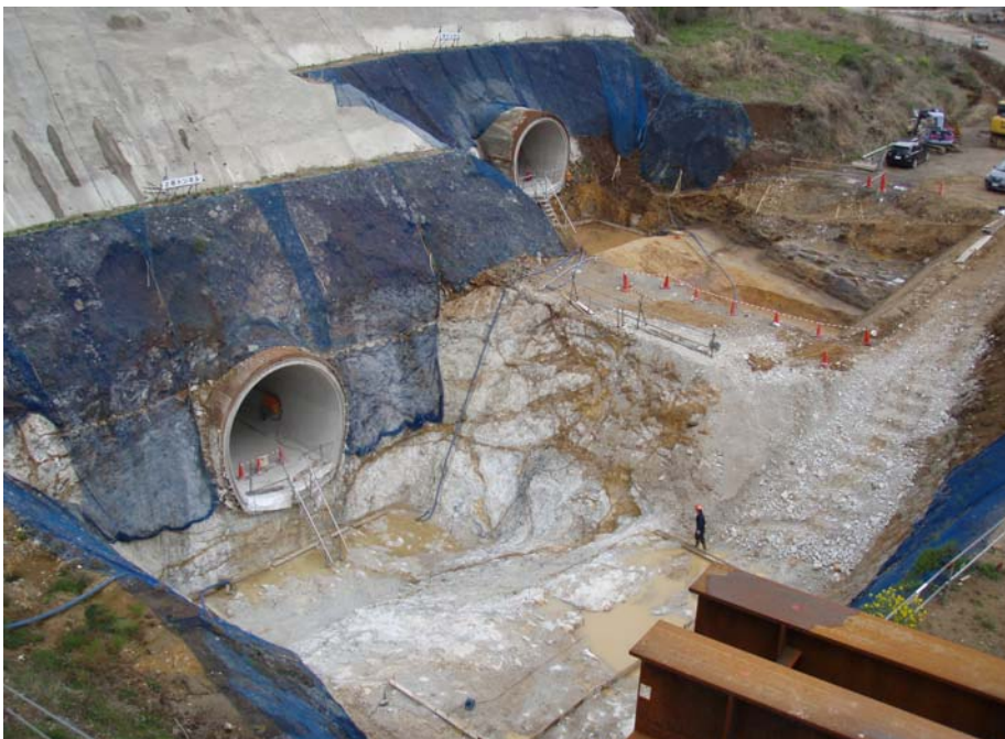
仮排水路トンネル施工状況
