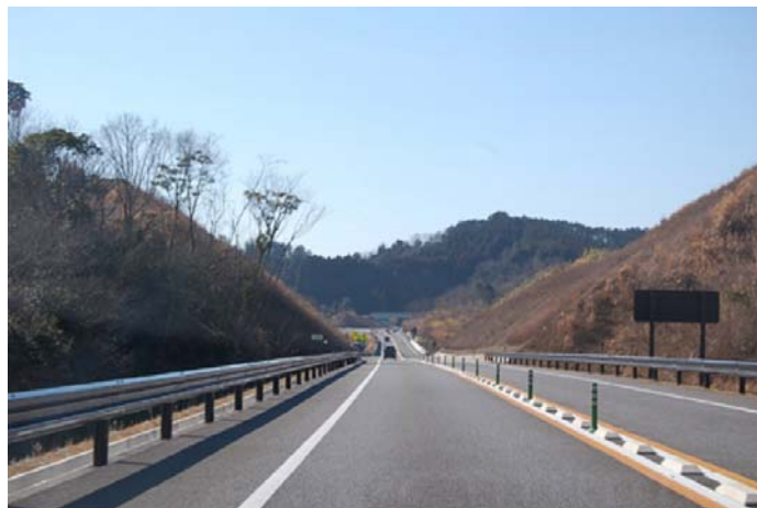
※写真：北方延岡道路（2工区）
