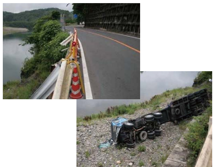
▼ 線形不良による大型車の転落（H19.6月発生）
