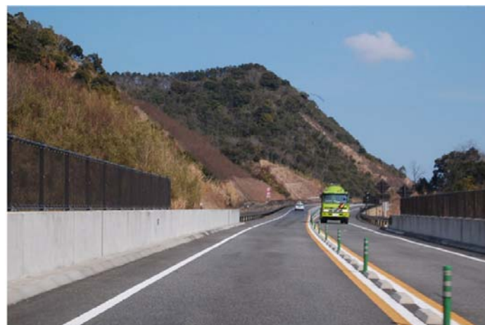
※写真：北方延岡道路（2工区）
