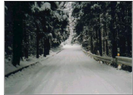
積雪時による通行障害
