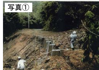
波当津川の氾濫により土砂流出した(県)古江丸市尾線 (H16. 10. 20)
