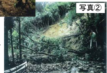
台風21号により地すべりが発生した国道388号 (H13. 10. 16)
