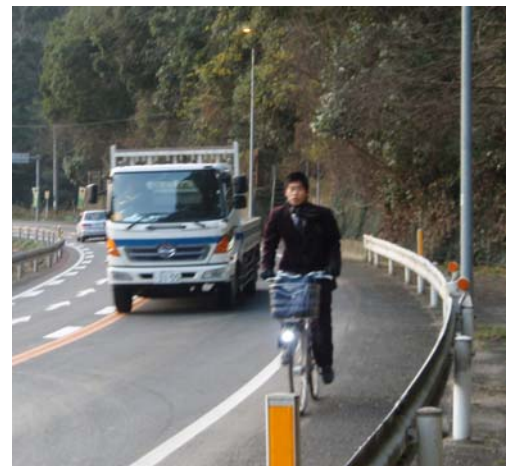
▲歩道未設置区間状況 (唐津市北波多合野)
