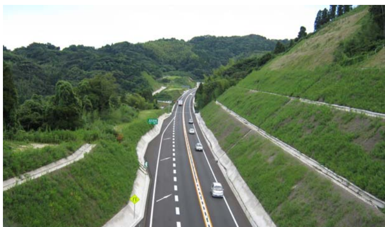
▲植物誘導吹付工法 唐津道路の施工例
