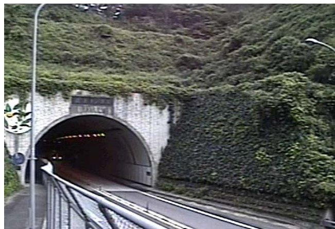
▲巖木トンネル坑口コンクリート擁壁緑化
