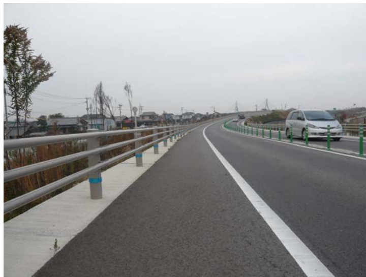
▼周辺景観との調和を考慮した防護柵（グレーベージュ）
