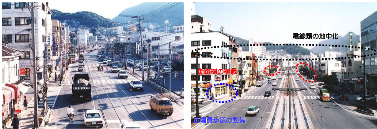
図 整備前後の道路空間の変化（新大工町付近）
