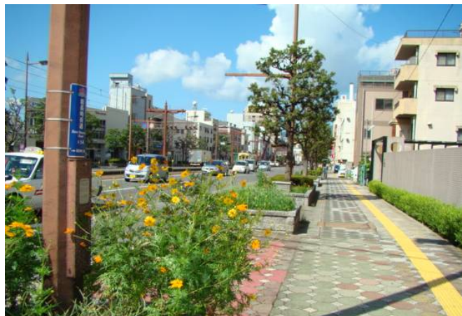
図 歩道整備後の状況（インターロッキングブロック舗装）
