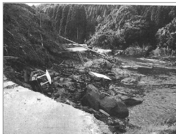
▲河川の氾濫で跡形もないほどに土砂を削りとられた町道
