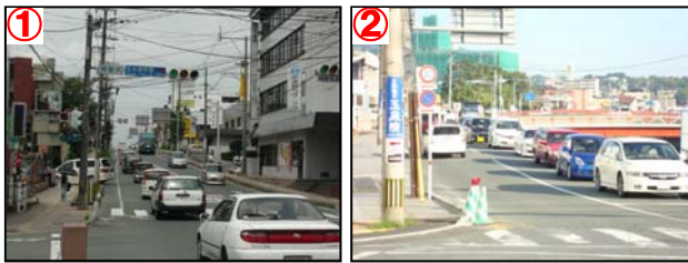
国道 208 号 (主)玉名八女線 ▲繁根木交差点の混雑状況(H23.2 供用前)
