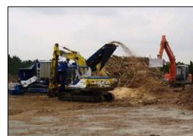
再資源化 (枯損木のチップ 化作業)
