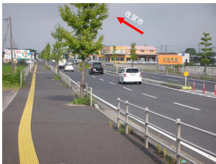
▲ 車道舗装を排水性舗装化 (国道 34 号神埼佐賀拡幅：堀立西～下湊)
