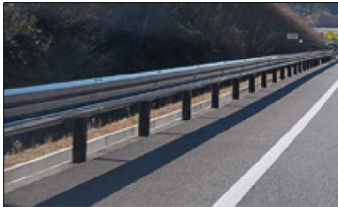
※写真：北方延岡道路(2工区)
