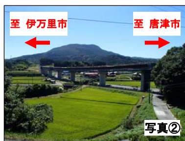
▲ 板治川橋(仮称) (伊万里市南波多町)
