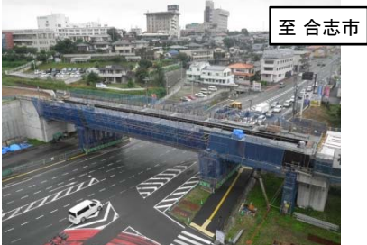
写真②: 須屋高架橋付近
