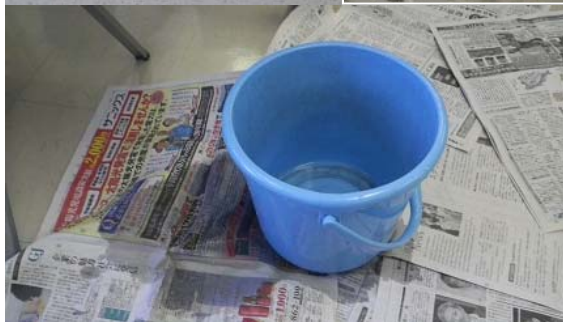
屋上防水劣化による雨漏り
