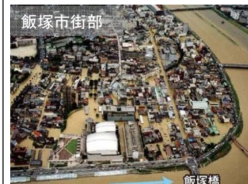
平成15年7月19日の出水浸水状況
