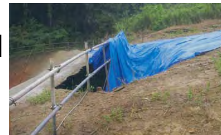
▲天端崩落状況(Ⅰ期線終点側坑口)
