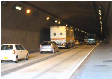
▲写真③ 筑豊烏尾トンネル西坑口
