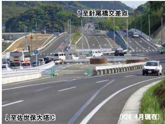
▲写真① 江上交差点立体整備
