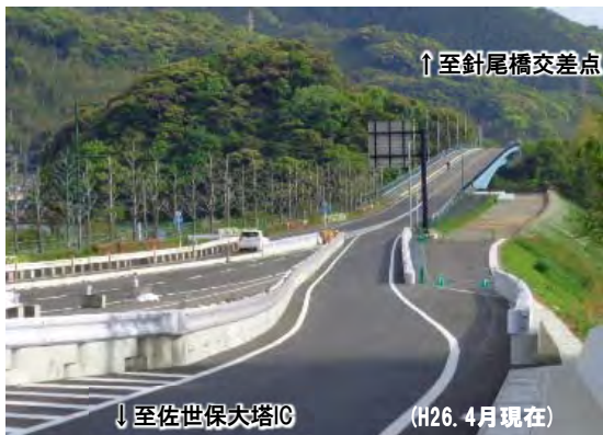
▲写真② 江上交差点～崎岡町ランプ間
