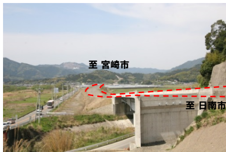
▲ 内之野川橋(仮称)付近(写真③)
