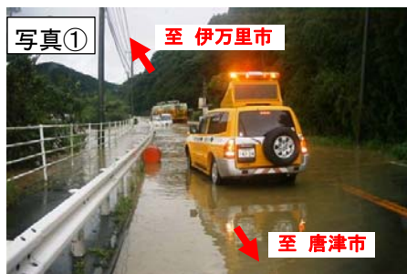
▲国道202号の路面冠水状況 (平成18年9月18日撮影)
