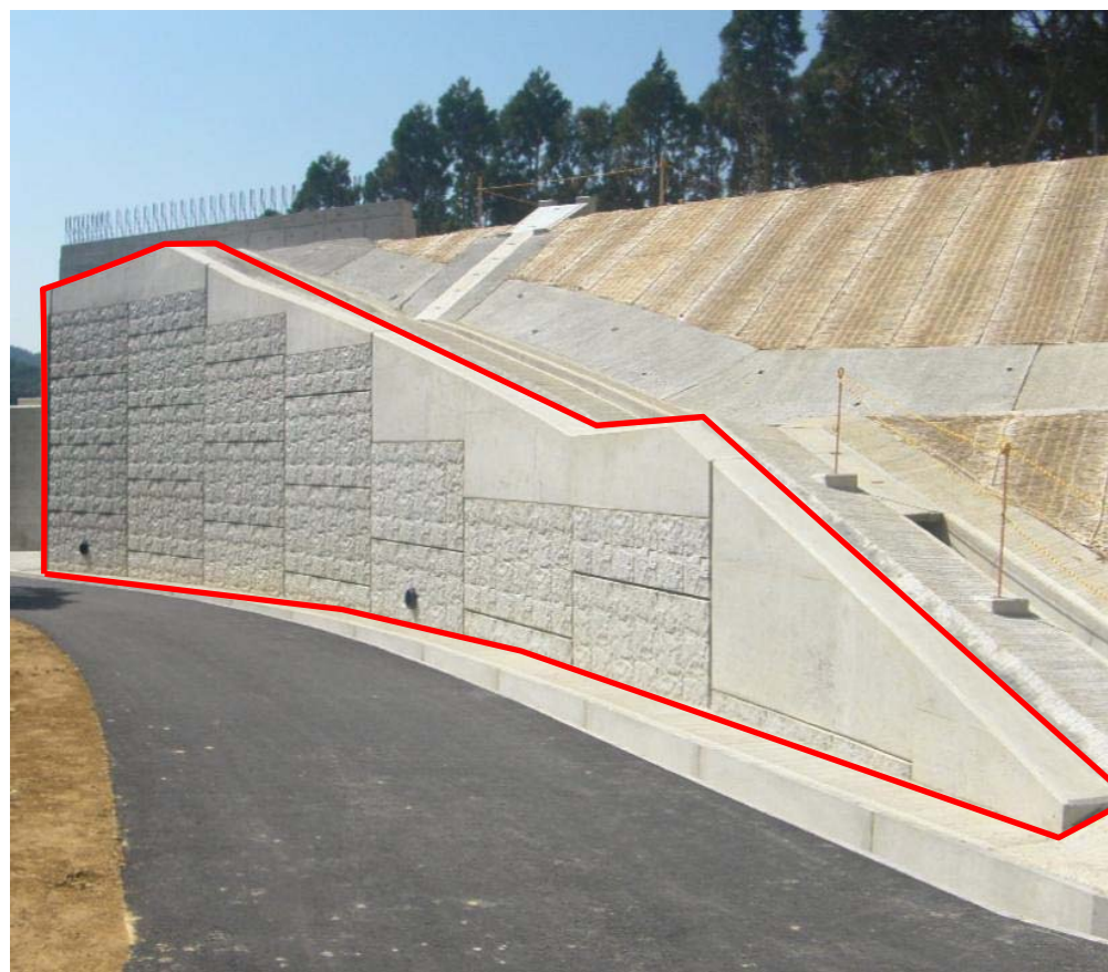
▲ 施工事例（伊万里市南波多町谷口地区）
