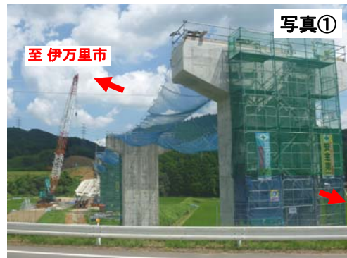
▲原屋敷橋（仮称）（H27.8月末時点） （伊万里市南波多）
