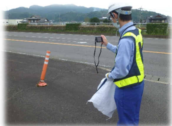
道路巡回（佐賀国道事務所）
