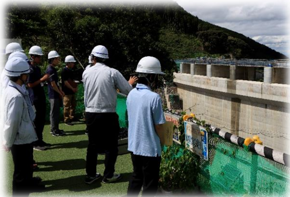
ダム建設現場（立野ダム工事事務所）
