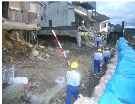
被災状況調査班: 河川(熊野川支川相野谷川)
