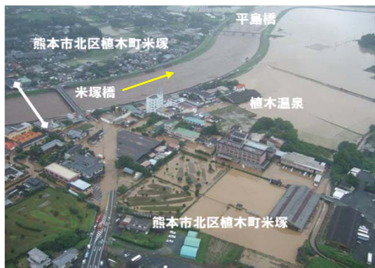
合志川（植木温泉街）の浸水状況（合志川4.2k）
