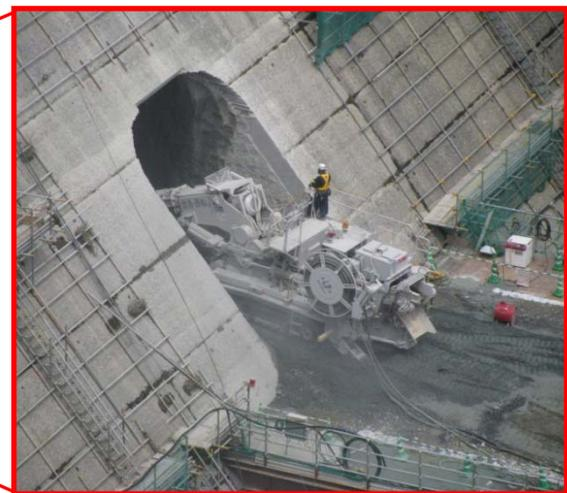
放流設備増設のための堤体削孔状況 (H25年5月撮影)
