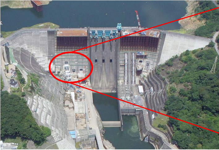
ダム下流側(H26年7月撮影)
