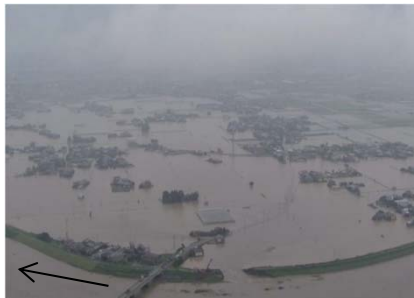
矢部川堤防決壊状況
