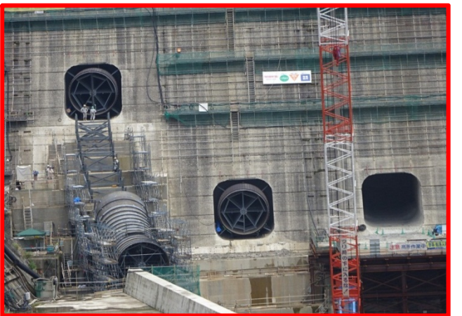
放流設備増設のための放流管設置の状況 (H26年6月撮影)
