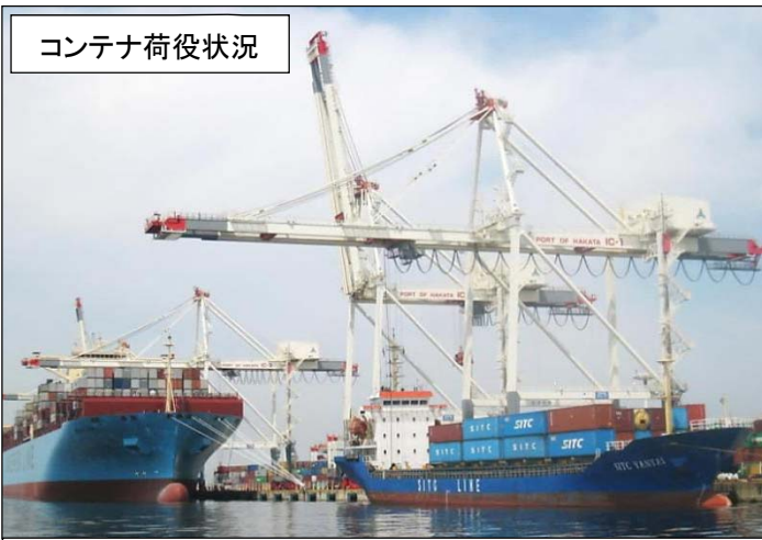
博多港（アライドシティ地区）国際海上コンテナターミナル整備
