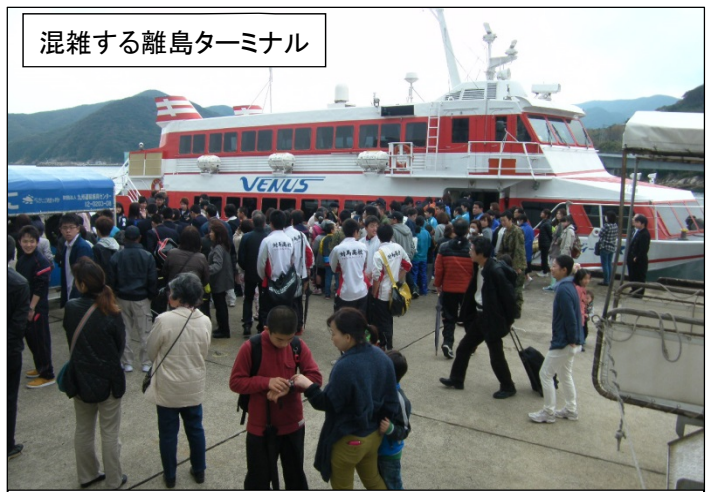
厳原港（厳原地区）離島ターミナル整備
