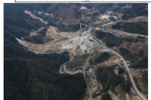
本体工事現況写真(H27年2月時点)
