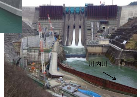
再開発工事現況写真(H27年3月時点)
