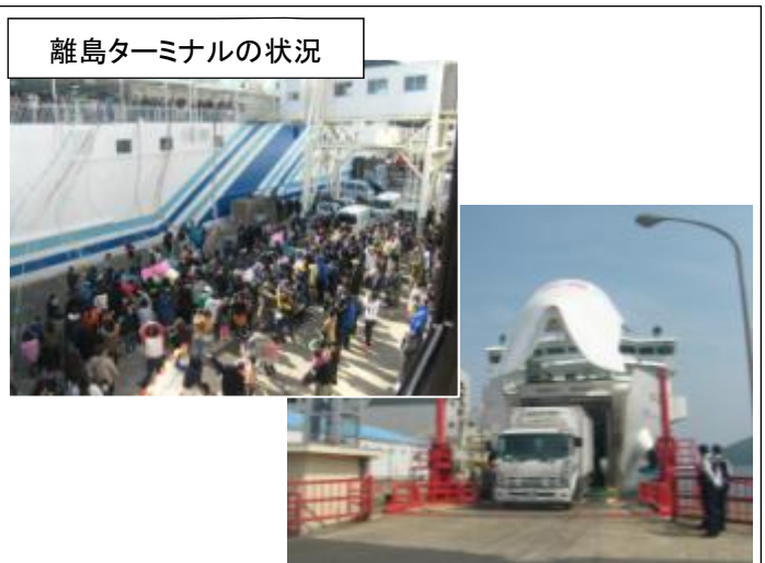
厳原港（厳原地区）離島ターミナル整備事業
