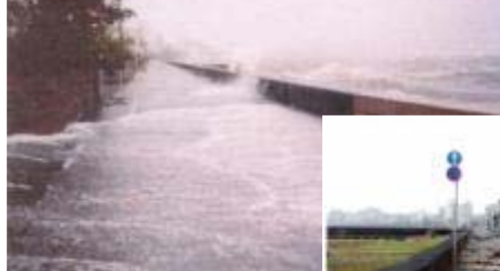
高波による越波状況
