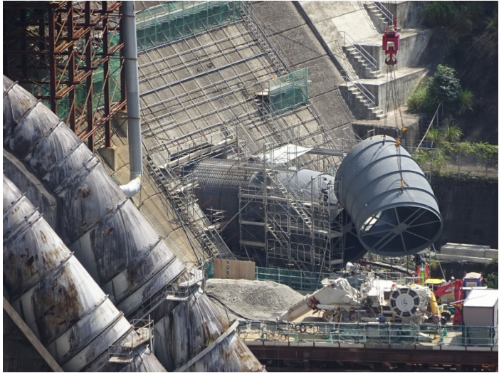
工事施工状況
