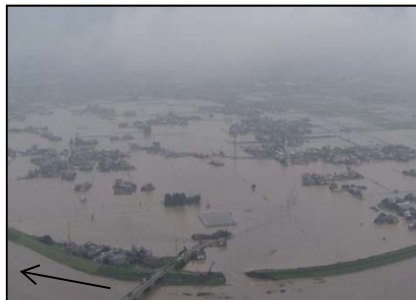
矢部川堤防決壊状況
