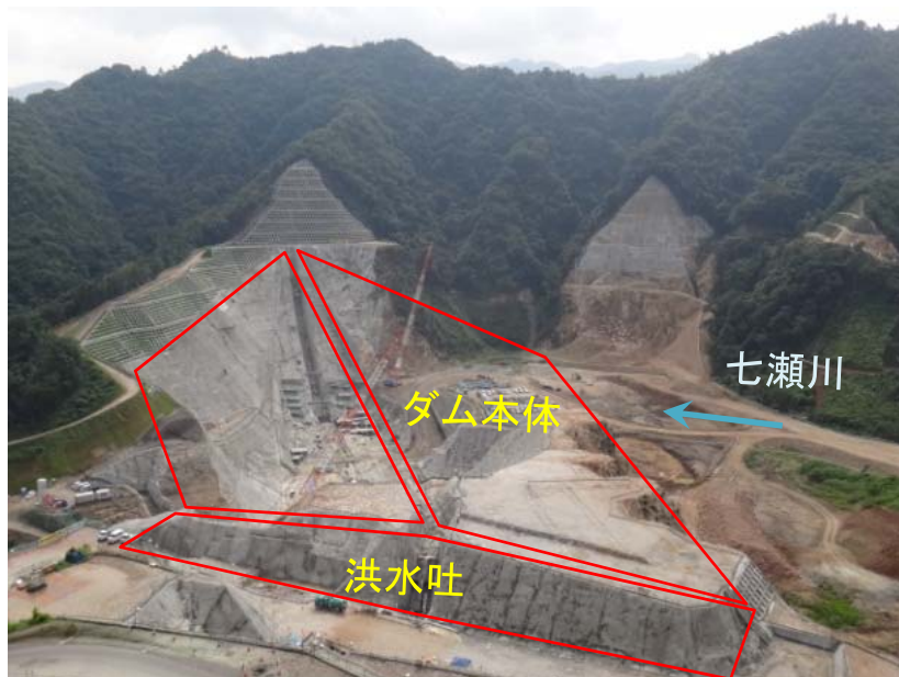
本体施工状況（基礎掘削完了） (H27. 8撮影)
