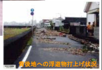
指宿港海岸直轄海岸保全施設整備事業
